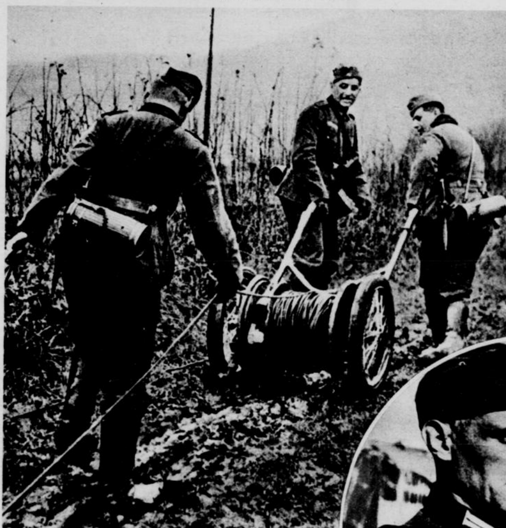
Verlegung schwerer Feldkabel Aufn. PK-Schlegel-PBZ.
