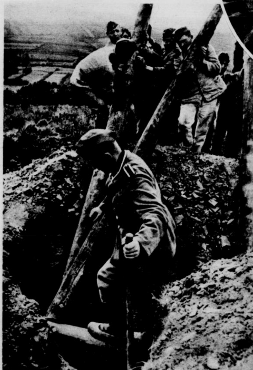
Der Mast wird gesetzt Aufn. PK-Wittke-PBZ.
