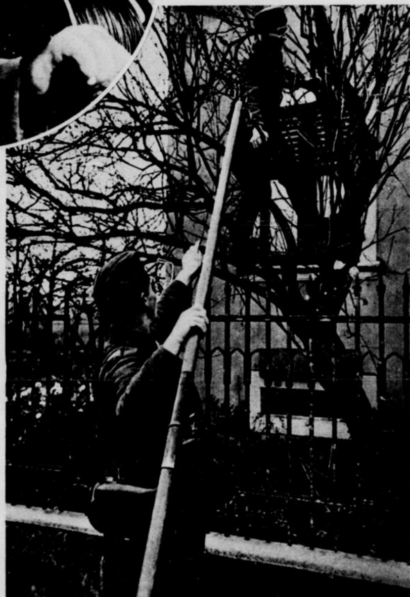
Mit einer Drahtgabel werden die Leitungen über Bäume und Sträucher gelegt Aufn. PK-Spieth-PBZ.
