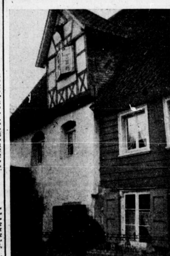
Fachwerkgebäude an einem Bruchsteinhaus in Breitenbruch
