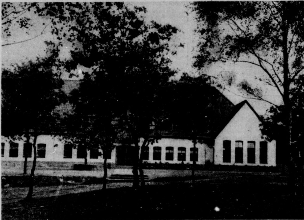
Ein Teil der Front. Rechts im Giebelbau der Feiersfundenraum Photo Smolarczyk
