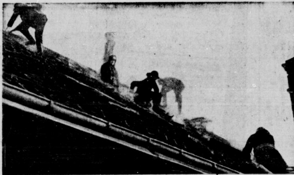
Die Männer der Feuerlöschpolizei mußten gefährliche Kletterkunststücke verrichten, um die Brandnester im Dach zu beseitigen. Photo: Sorani (W)
