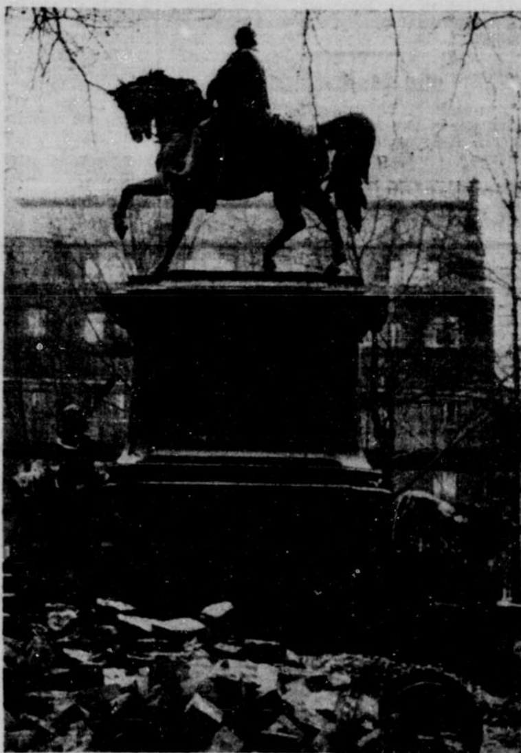
Das Bild des Denkmals wurde während der jetzt stattfindenden Arbeiten auf dem Brausenwerther Platz aufgenommen.
