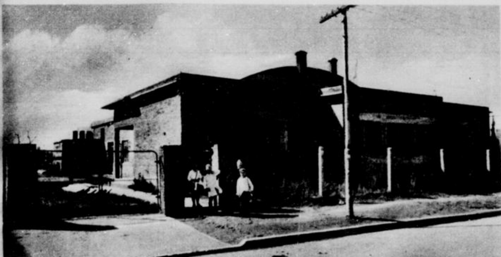
Die Schule ist fertig bis auf die Fassade
