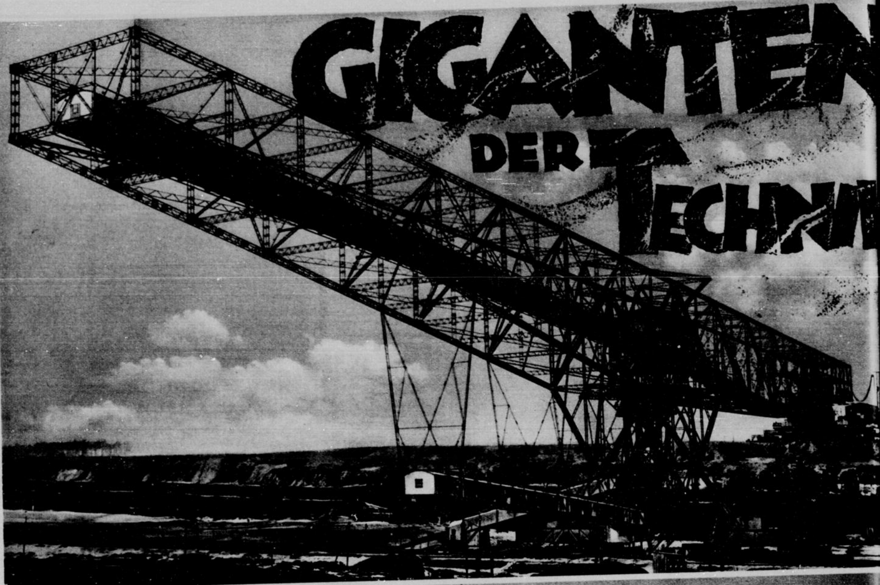
Eine riesige Abraum-Förderbrücke. Im Reichselektrowerk bei Zschornowitz ist eine neue Abraum-Förderbrücke von gewaltiger Leistungsfähigkeit in Betrieb gesetzt worden. Die Brücke hat eine Länge von 350 m, sie ist imstande, täglich 40 000 cbm Erde zu bewegen.
