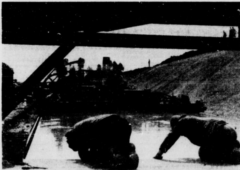
Die große Betonmaschine vom Häuschen der Verputzer aus gesehen.
