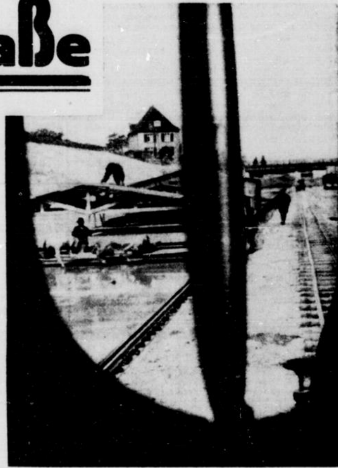
Aus dem Fenster der Feldbahnlokomotive geht der Blick auf die Betonstraße
