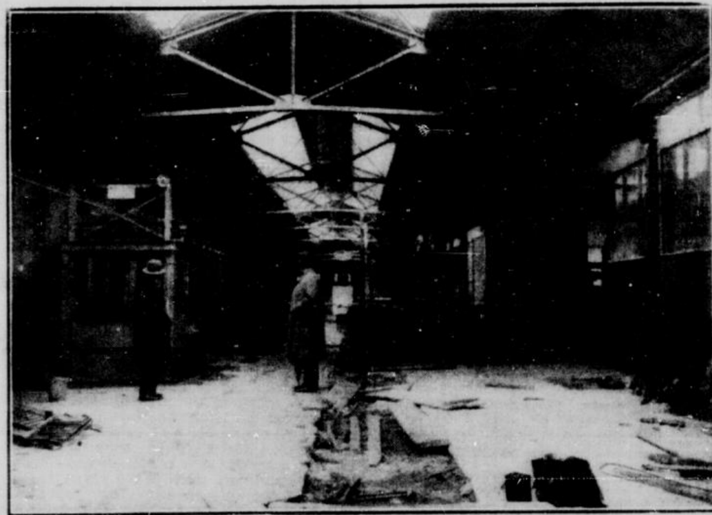
Auf diese Weise wird neuer Raum für die Kälber geschaffen.
