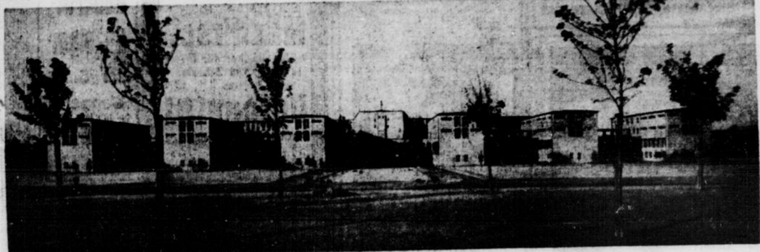
Die sechs Flügelbauten der rückseitigen Universitäts-Front in Köln Der an dieser Seite liegende große Rasenplatz soll Sportzwecken dienen.
