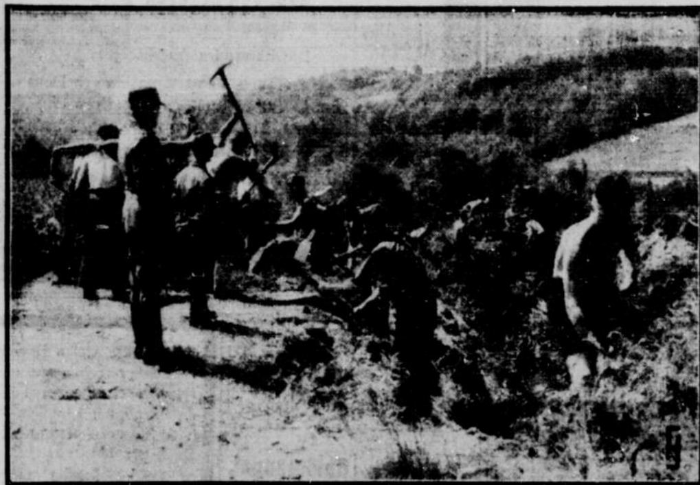
Die Arbeitsstelle am Hiddinghauser Berg
