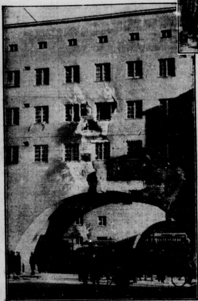
Einschlagstellen von Granaten am Karl-Marx-Hof, der großen Wohnburg in Wien-Heiligenstadt, die erst nach schwerer Artillerie-Vorbereitung in heftigen Nahkämpfen durch die Bundestruppen besetzt werden konnte.
