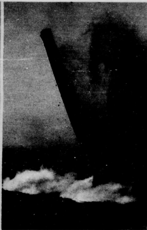
Die dritte dumpfe Explosion schleudert den Schornstein senkrecht in die Höhe. Schwerfällig legt er sich um und stürzt senkrecht herab
