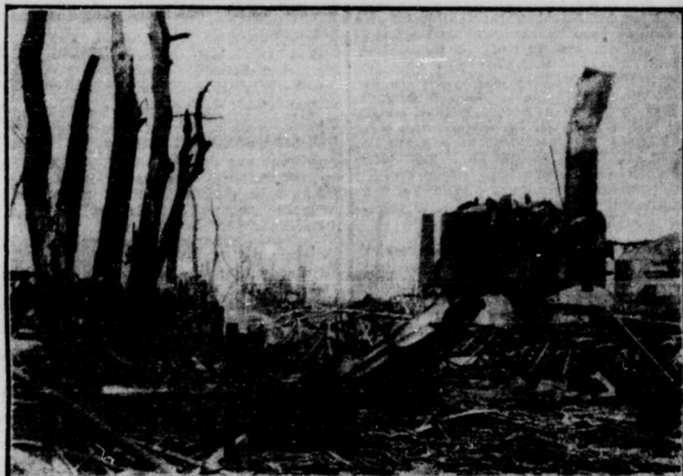
Hier stand der Gasometer
