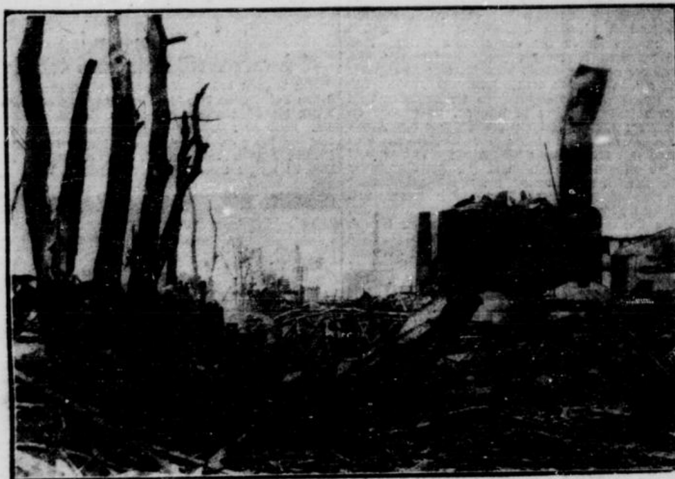
Hier stand der Gasometer
