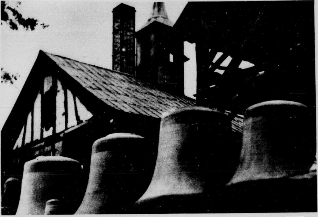
Blinde Glocken aus Lehm vor der Gießerei
