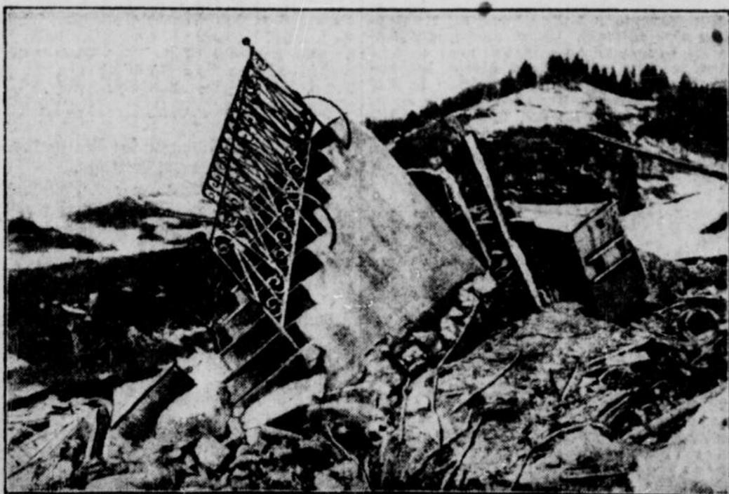
Eine Treppe, ein kleiner Trümmerhaufen, das ist alles, was von einem Wohnhaus übrigblieb.
