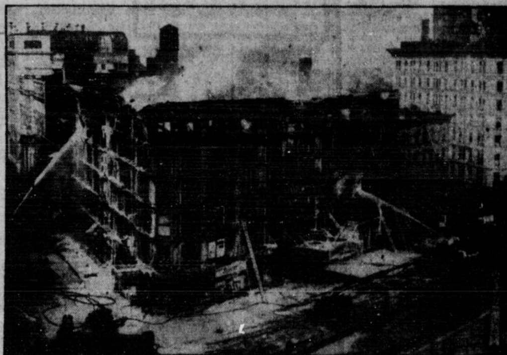
Am Broadway, dem New Yorker Vergnügungsviertel, brach kürzlich in einem Kinopalast, kurz nachdem das Publikum das Theater verlassen hatte, ein Brand aus. Die Wehren hatten die ganze Nacht mit der Bekämpfung des Feuers zu tun. Unser Bild zeigt die Löscharbeiten in den frühen Morgenstunden; die starke Kälte ließ das Löschwasser an der Front des brennenden Gebäudes bald wieder zu Eis erstarren.
