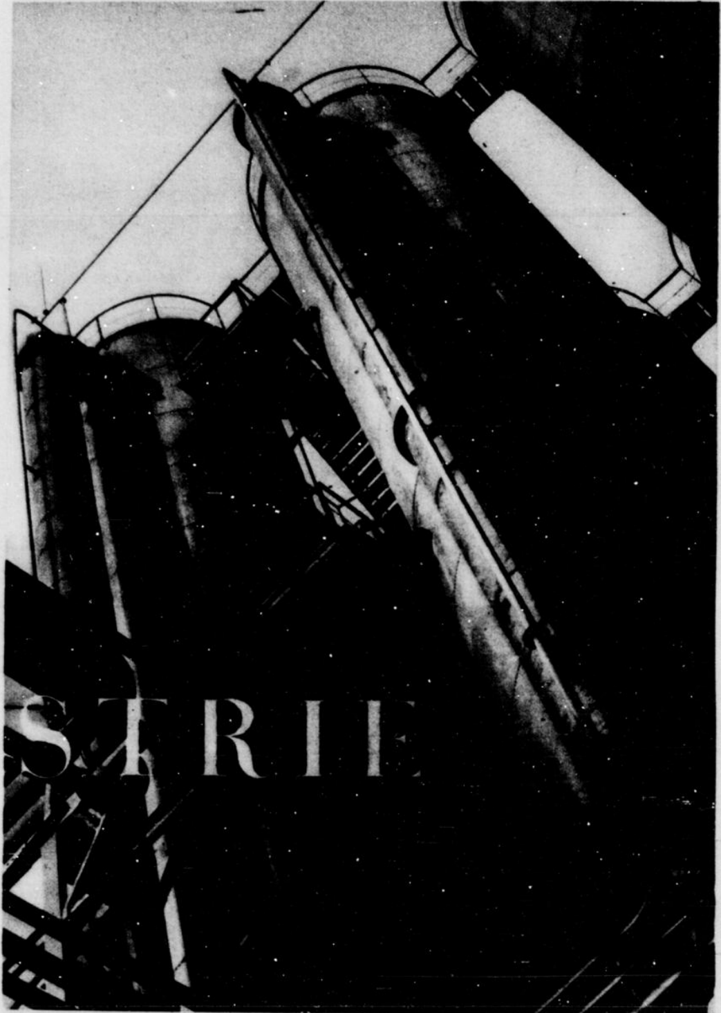
Benzol- und Ammoniakwäpfer auf einer modernen Kolerei Aufnahmen Prof. Barthelme, Bonn
