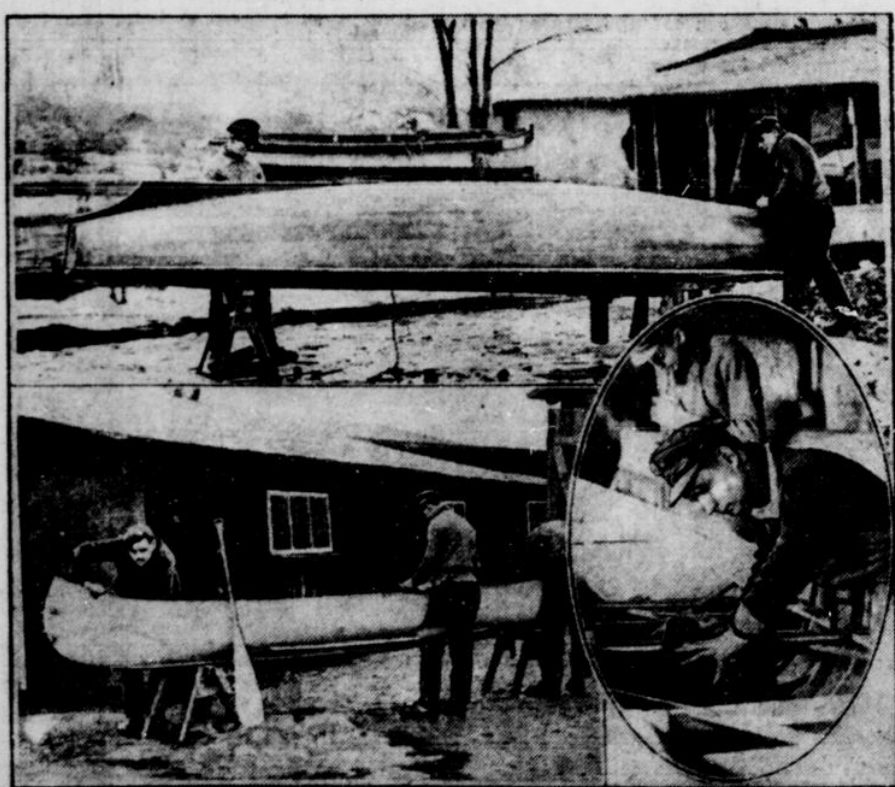
Auf den Bootswerften werden jetzt überall die Boote aller Art für die neue Saison in- stand gesetzt. — Oben: Das Abziehen des alten Bootslades. Unten: Erneuerung des Bo- denbelags eines Kanus; im Oval: Einsetzen der Rostige.
