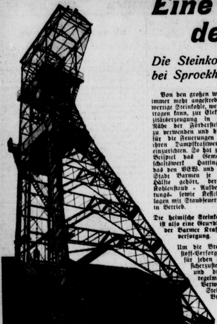
Förderturm auf Zeche „Alte Haase“.
