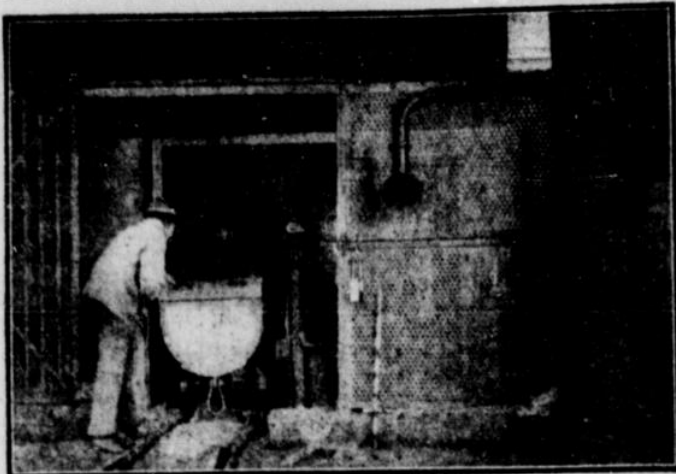
Schachteingang der Zeche „Kleine Windmühle“. Der Schacht führt schräg in die Erde.
