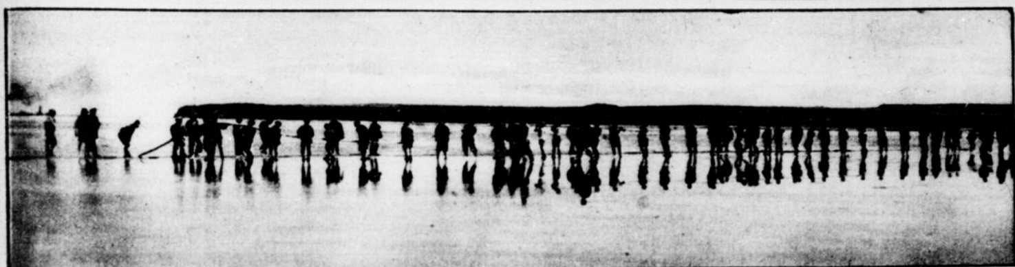
Auskleppen eines Kabels über eine Lücke
