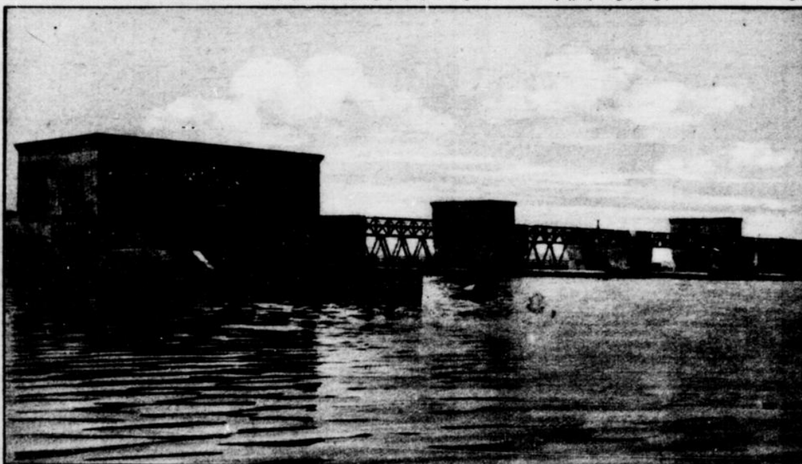
Blick vom Stautee auf die Wehranlage mit der großen Wassertrastanlage (links)
