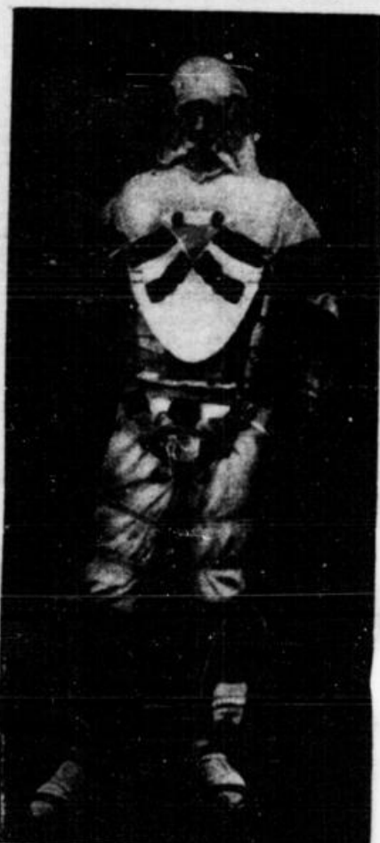
Der Anzug für Überseeflieger Ein Rettungsanzug für verunglückte Ozeanflieger, der gegen heftige Schuss gewährt und es dem Verunglückten ermöglicht, sich mehrere Stunden über Wasser zu halten Aldo. Kaydano View Co.
