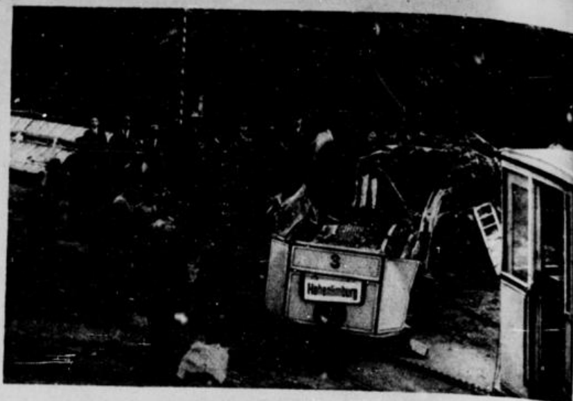
Das Straßenbahnplätt bei Herlohn Das Bild zeigt die Überbleibsel des zerfallenen Straßenbahnwagens
