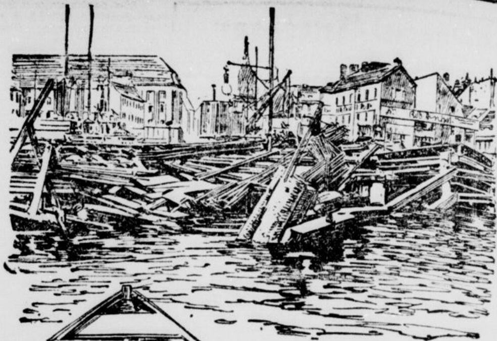
Die Ueberbrückung der Berliner Untergrundbahn: Der gebrochene Fangedamm in der Spree, der zum Bau des Spreetunnels errichtet wurde.
