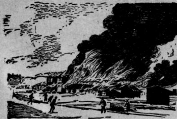
Brand der Roten-Garde-Kaserne, welche von dort untergebrachten gefangenen Rotgardisten in Brand gesteckt wurde.
