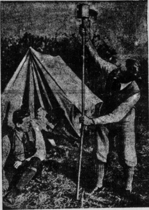
Die Aufstellung des Blitzableiters neben dem Wochenendzelt.
