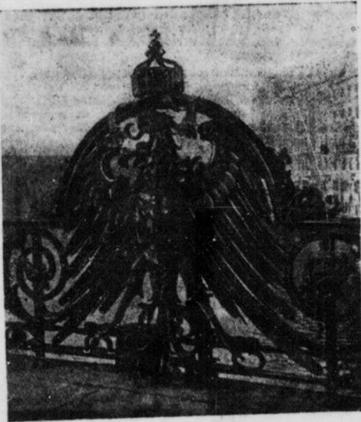
Der schmiedeeiserne Reichsadler an der Weidenammer Brücke in Berlin, der auf Veranlassung des Polizeipräsidenten wieder mit der alten Kaiserkrone, die ihm in den Umsturztagen von 1918 genommen worden war, versehen wurde.
