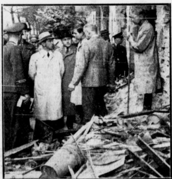
Presse-Hoffmann Dr. Goebbels besucht zerstörte Wohnhäuser Reichsminister Dr. Goebbels läßt sich von den Bewohnern eines beim nächtlichen Angriff durch britische Bomben zerstörten Wohnhauses über den heimtückischen Überfall Bericht erstatten
