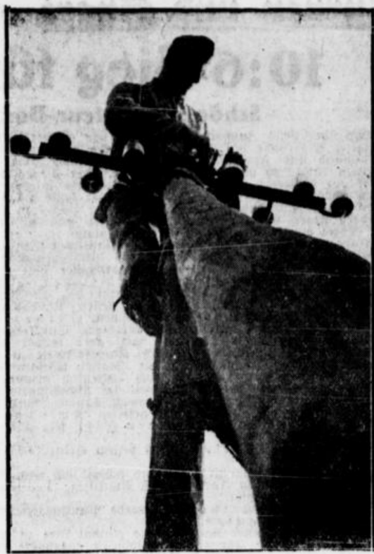
PK. — Fremke — Presse-Hoffmann Eine Fernsprech-Baukompanie beim Leitungsbau Mit fester Hand wird hoch oben am Quergestänge der Draht abgebunden
