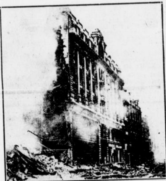
Zerstörte Lagerhäuser in London
