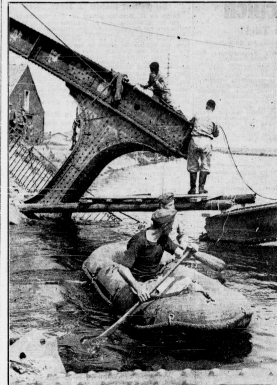
Die Trümmer einer geſprengten Brücke in Frankreich werden von Männern der Techniſchen Nothilfe befreit. Die Eſenſteile müſſen hierbei in kleinere Stücke geſchnitten werden, da wegen der Verſchwiegenheit viel ſchwerere große Krane herangeſchafft werden können.
