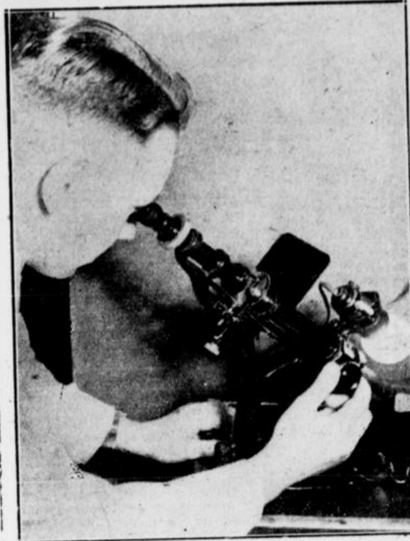
Aufnahme: E. Söhngen Sorgfältig werden die Brillenränder geschliffen und in das Brillengefäß eingepaßt.
