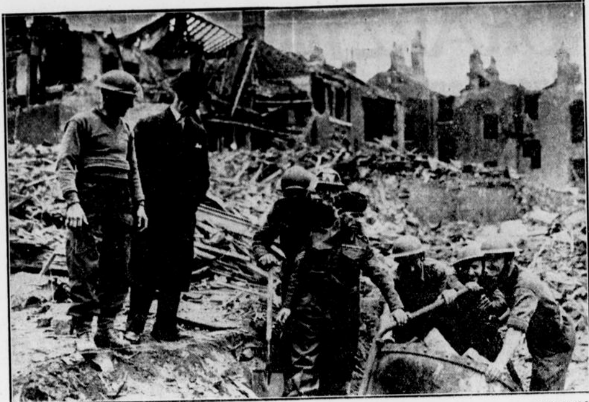
Trümmer häufen sich auf Trümmer... Die von Winston Churchill herausgeforderten Bergungsangriffe rabieren Englands Kämpfungs- zentren und Versorgungsanlagen aus. Unter Bild zeigt Aufräumarbeiten in einem Industrie- viertel der britischen Hauptstadt — ein hoffnungsloses Beginnen
