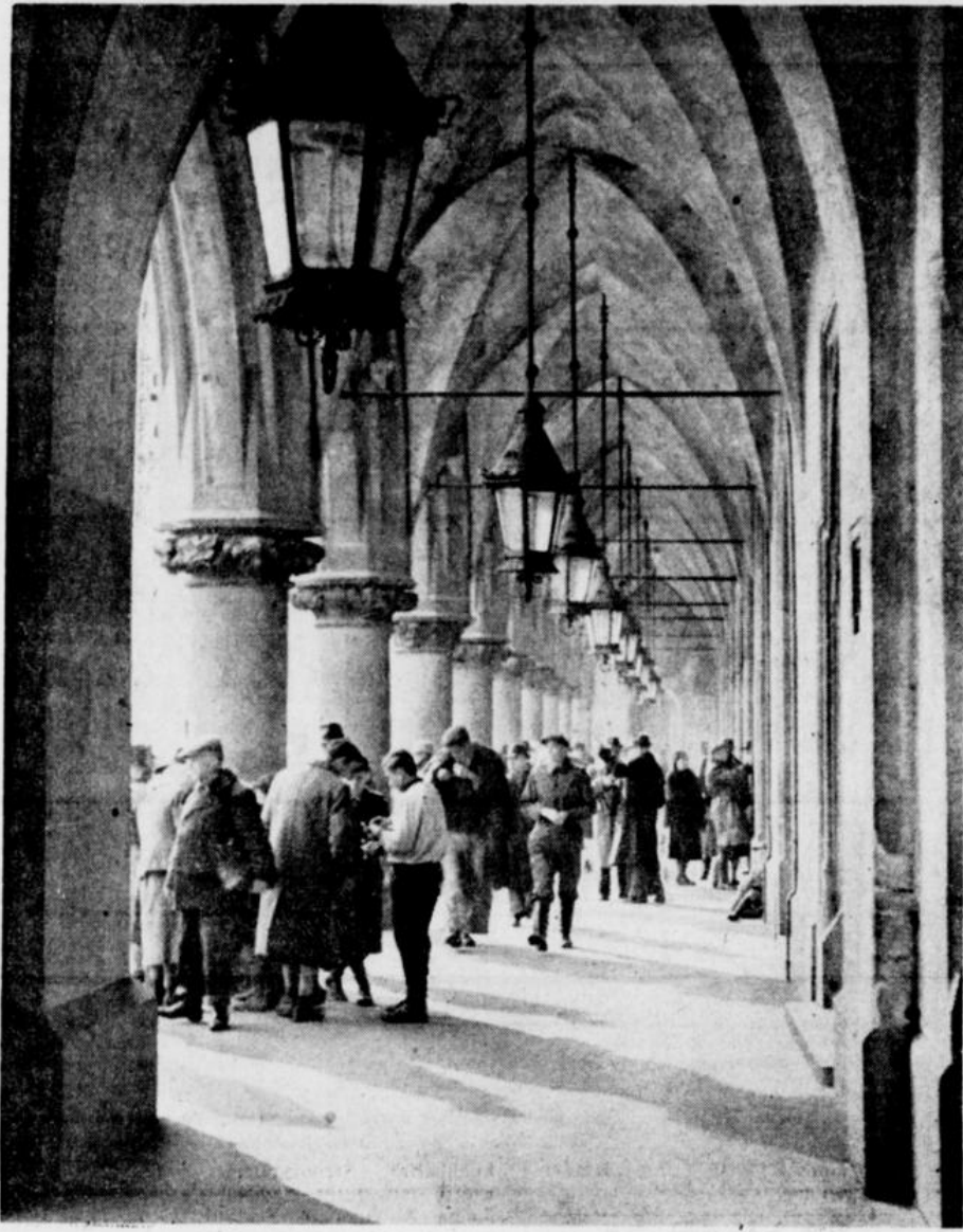
Der Laubengang der Tucherhalle
