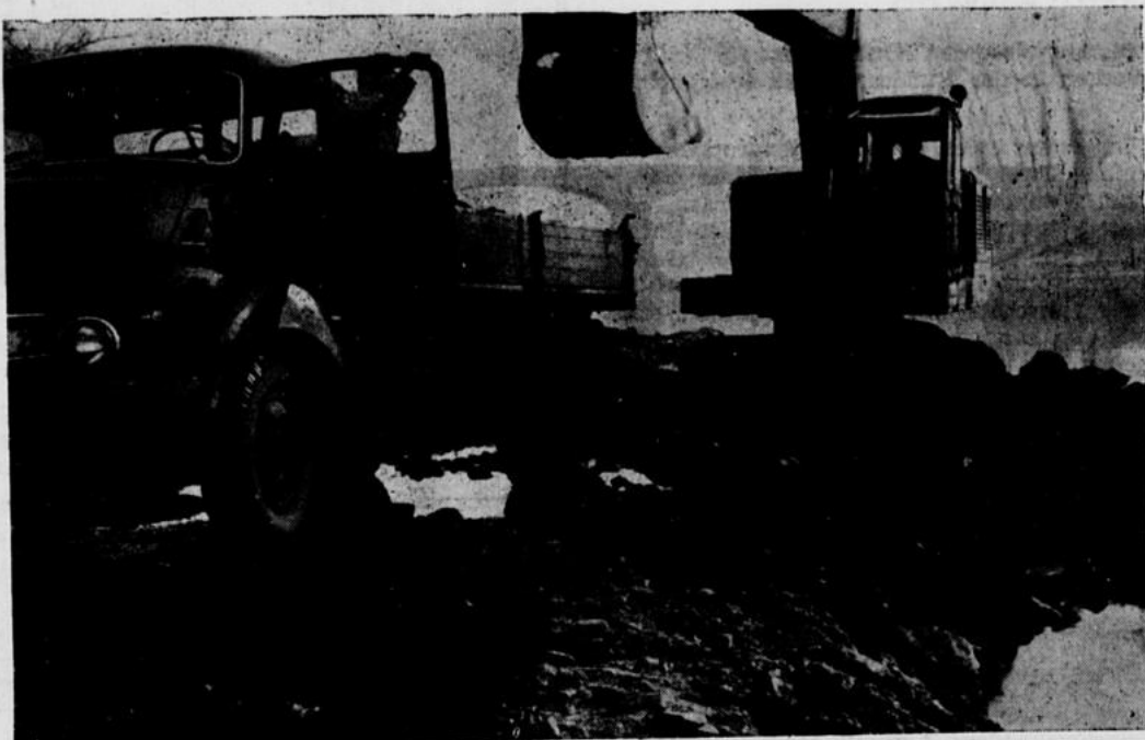
Bei ideal niedrigem Wasserstand werden gegenwärtig weitere 7000 Kubikmeter Kies aus der Fahrrinne des Altarmes ausgebaggert. Kostenpunkt: 15 000 DM. Foto: HVZ
