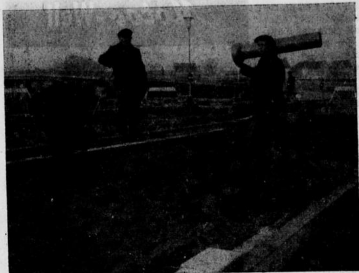
Nachdem das „Honnefer Kreuz“ fertiggestellt ist und jetzt der Bahnhofsvorplatz um einen größeren Bushalteplatz erweitert wird, tritt die Schäßigkeit des Bahnhofsgeländes noch stärker hervor. Unser Bild zeigt die Arbeiten am Bahnhofsvorplatz. Fotos: HVZ
