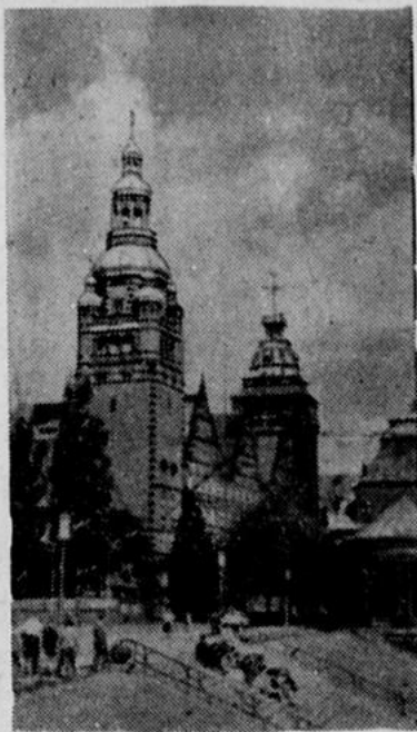
Stettin 1962: Auf den Treppen vor dem Regierungsgebäude der ehemaligen Hauptstadt von Pommern, auf der Hakenterrasse von Stettin, sonnen sich junge Polen. Stettin ist heute Sitz der polnischen Verwaltung der Woiwodschaft Szczecin.
