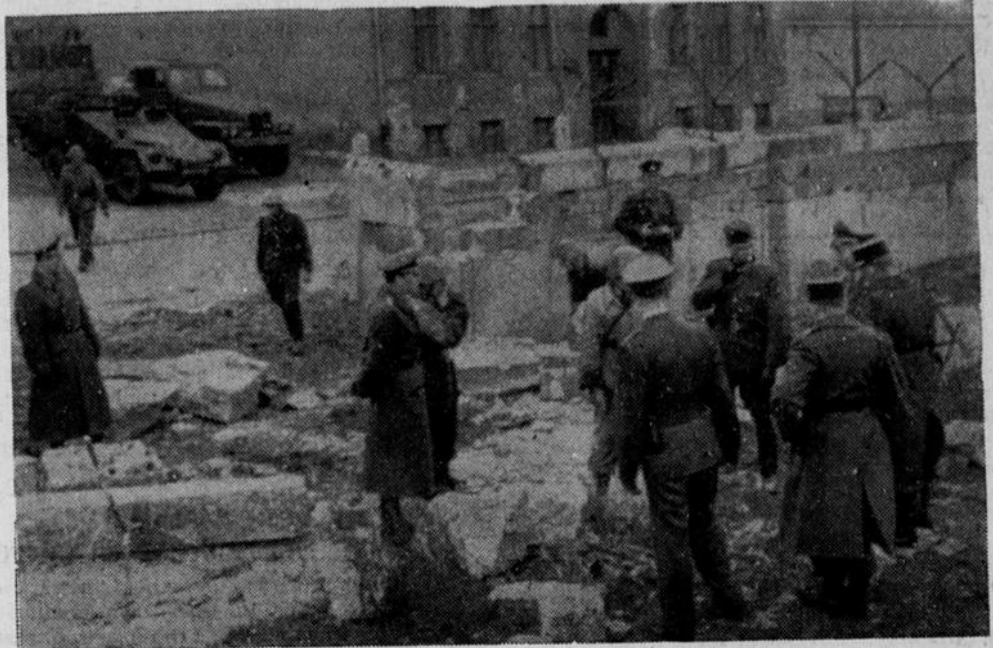
Mit einem Schwerlastwagen, einem mit Mörtel beladenen Kipper, durchbrachen zwei junge Ostberliner Arbeiter gestern die Sperrmauer des Sowjetsektors von Berlin. Die Mauer brach in etwa zwei bis drei Meter Breite ein. Unser dpa-Bild zeigt die Durchbruchstelle mit vorn zwei Westberliner Polizisten und zwei französischen Soldaten genau an der Zonengrenze stehend. Ihnen nun zwei Meter gegenüber Volkspolizisten bei Aufräumarbeiten. Im Hintergrund rechts ein Lkw des gleichen Typs, mit dem die Flucht gelang; links ein sowjetzonaler Panzerspähwagen.
