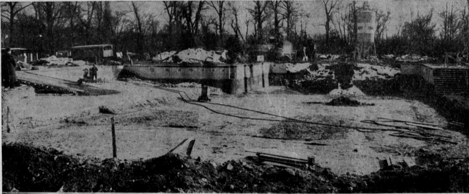
Trotz des schlechten Wetters sind in den letzten Wochen die Arbeiten zur Neugestaltung des Schwimmbades fortgeführt worden. Das Hauptbecken, das aus dem jetzigen Mineralwasserbecken geschaffen wird, wird in Kürze zum Betonieren verschalt.
