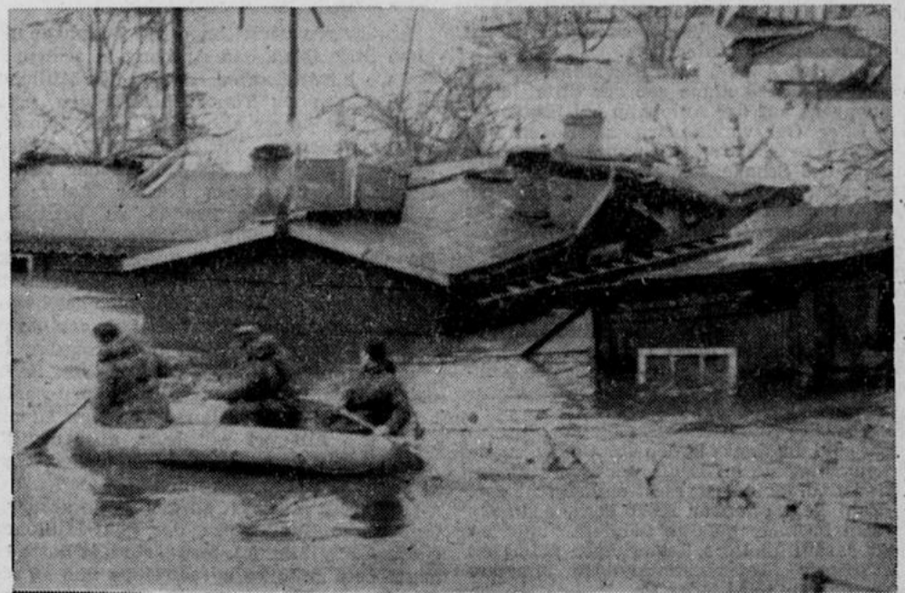
Unser dpa-Bild zeigt das weithin überschwemmte Gelände des Hamburger Stadtteils Wilhelmsburg und einen Rettungstrupp Bundeswehrsoldaten mit einem Schlauchboot.
