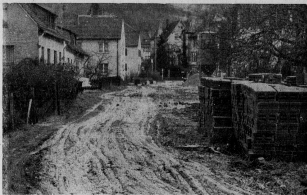
Regen und Bauarbeiten haben die „von-Stauffenberg-Straße“ in ein Schlammbad verwandelt. HVZ-Foto: Günter Groot
