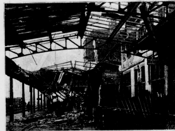
Der durch den Wirbelsturm beschädigte neue Plochingener Bahnhof.
