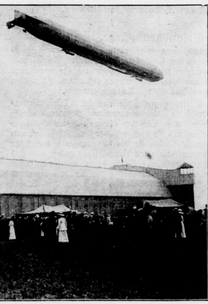
Der Leipziger Luftschiffhafen. Dort, wo vor 100 Jahren die Völkerschlacht geschlagen worden, ist ein Werk modernster Technik entstanden: die neue Luftschiffhalle. Mit ihren Maßen von 194 Meter Länge, 69 Meter Breite und 32 Meter Höhe ist sie die größte bisher gebaute Halle und bietet 2 Luftschiffen von Zeppelins größter Konstruktion Raum. Wenn ein Luftkreuzer zur Landung geschritten ist, öffnen sich ihm die Riesentore, spielend, geräuschlos, durch vier Elektromotoren in Bewegung gesetzt. Sollten diese versagen, so ist durch eine Maschinenanlage dafür gesorgt, daß zwei Mann durch ihre Muskelkraft diese Arbeit verrichten können. Um Sonnenstrahlung zu vermeiden, läßt man das Licht durch grüne Verglasung gedämpft einfallen. Rings um die Halle dehnt sich eine Fläche von 300.000 Quadratmetern, der neue Flugplatz Leipzig. Zehn in Eisenbeton aufgeführte Flugzeugschuppen, die noch im Bau sind, umgeben den Platz. Für die Fällung der Luftschiffe werden ständig mehr als 600 Tiaischen vorrätig gehalten, die 14.000 Kubikmeter Wasserstoff liefern können.
