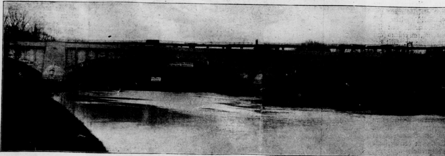
Die Brücke kurz vor Vollendung.
