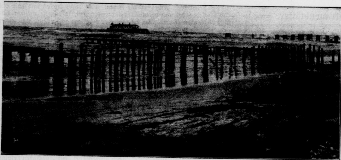
Sturm- und Wasserschäden: Die Sturmflutverheerungen im Ostseebad Wisdrow. Im Vordergrund die Ueberreste der zerstörten Ferienbadeanstalt, im Hintergrund die von den Fluten durchbrochene, 360 Meter lange Kaiser-Friedrich-Seedecke; auch das auf dem Brückentopf befindliche Ne l'aurant wurde stark beschädigt.
