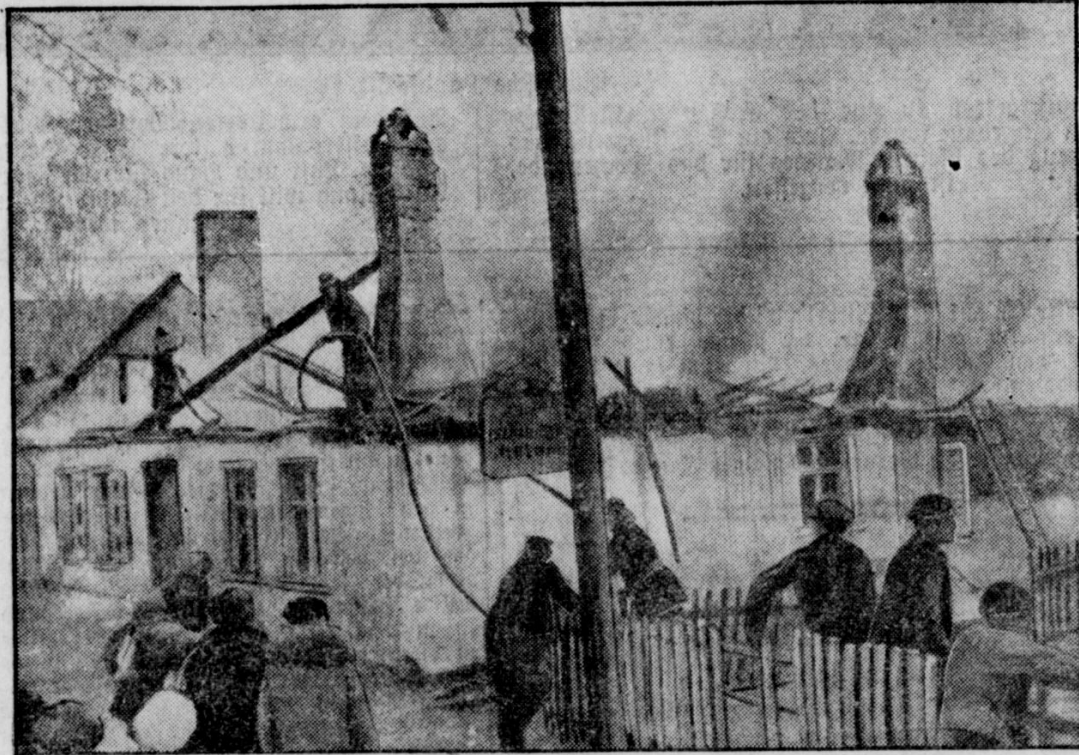
Die Feuerwehr bei den Arbeiten an der Brandstätte.
