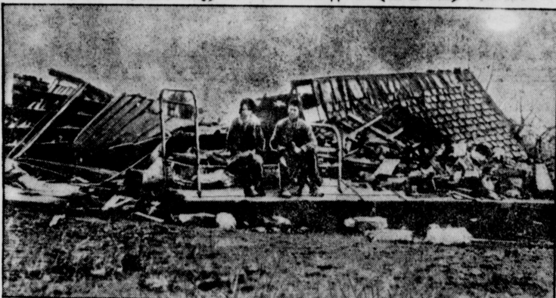
Ein Ehepaar, dessen drei Kinder ums Leben kamen, auf den Trümmern seines zerstörten Hauses. Mehrere Staaten der südwestlichen USA.
