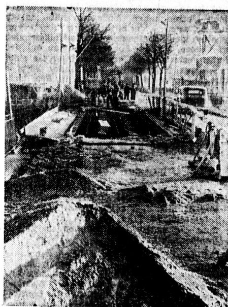
Berge von Baumaterial an der neuen Brücke
