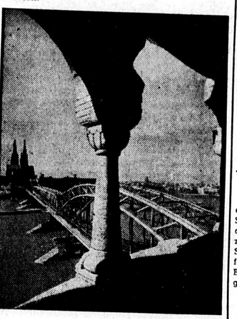
hitten hinein in das Herz Kölns führt die Hohen- allern-Brücke. Sie ist ein Lebensnerv, der die stark störte Stadt mit der rechten Rheinseite verbindet. icht nur Fußgänger passieren auf ihr den Strom, 1 Züge schickt die Bundesbahn täglich über die Gleise nach Köln hinein — aus Köln hinaus
